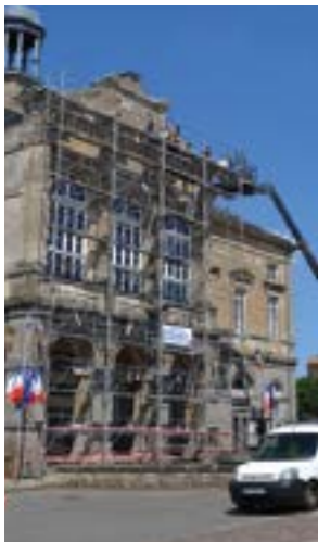
En mai dernier, un imposant échafaudage a été installé plusieurs jours devant la mairie par une entreprise de couverture. L'objectif : remettre en état une partie de la toiture en zinc, abîmée par le temps et qui menaçait de tomber.
