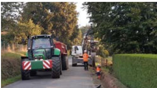
Depuis le 2 septembre et jusqu'à mi-octobre, le réseau d'eau potable de la commune déléguée de Rouellé, géré par le SDeau 50, est remis à neuf. Les canalisations sont remplacées sur une distance d'1,2 km ainsi que tous les compteurs des abonnés. L'équipement datait de 1972. La municipalité réalisera ensuite des travaux de sécurisation du bourg, en redessinant la voirie et en matérialisant des accès piétonniers. Cette deuxième tranche se terminera début décembre .
